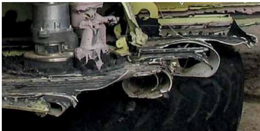
Rys. 2. Widok loków powybuchowych poszycia spodniego oderwanej końcówki odejmowanej części lewego skrzydła.
